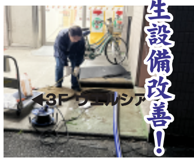
市川ビル5の湧水ポンプ設置
